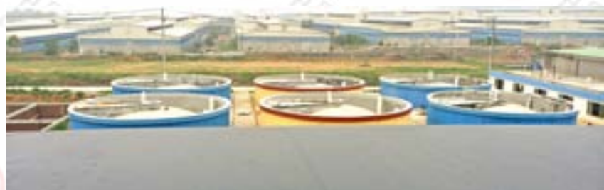
新建 50000 立方米黑膜沼气池及 8000 立方米混凝土沼气池
