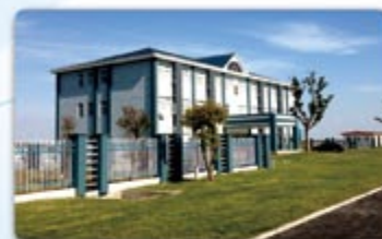
种公猪站大楼
