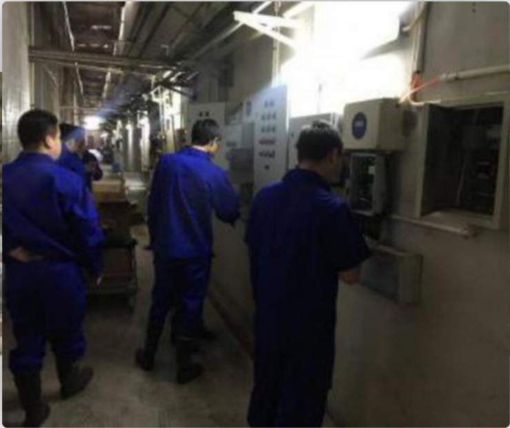
环 设备安装中
