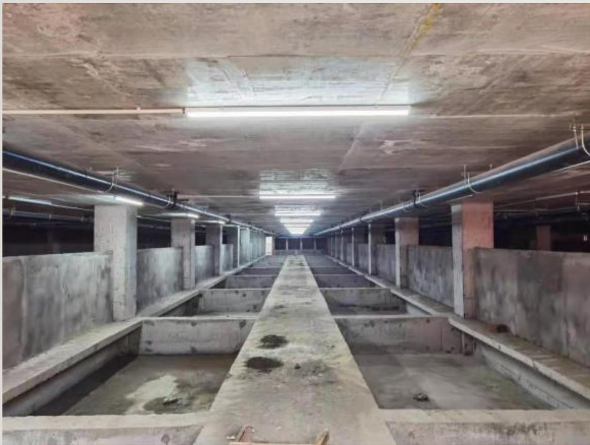
尽量使用水泡粪工艺，巧妙的设计反梁，天花板是一个平面，这样不管是料线还是粪管都不用穿梁，这样可以大大降低你的层高，基本控制到3米以内。
