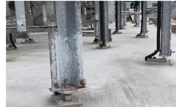
无需吊车，无需拆卸料塔料线即可完成改造工作；2人、3小时之内即可完成1个料塔改造工作
