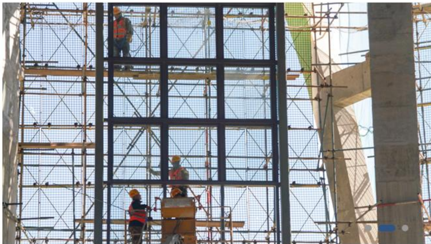
天气渐暖 我国在建最北高铁站全面复工
