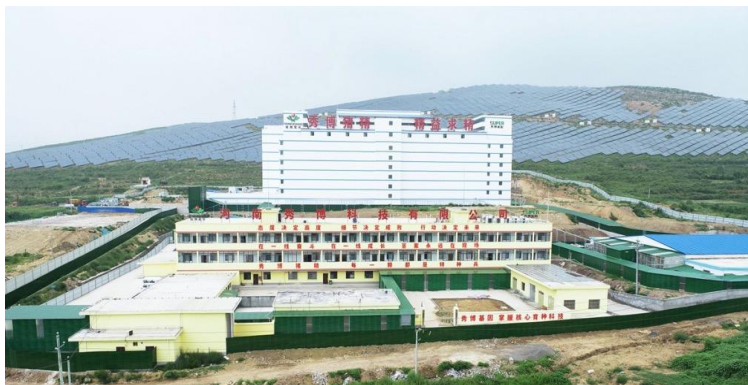
智能楼房公猪站
