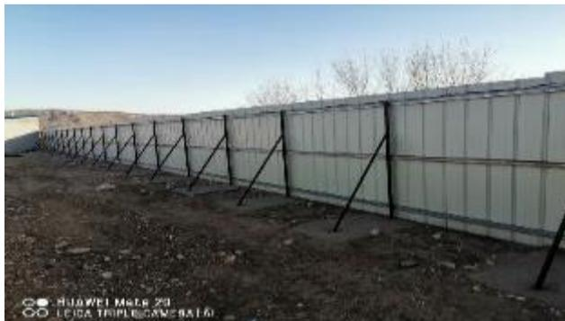
**外墙：**用2米高、厚度0.3mm的波浪形彩钢瓦封闭
